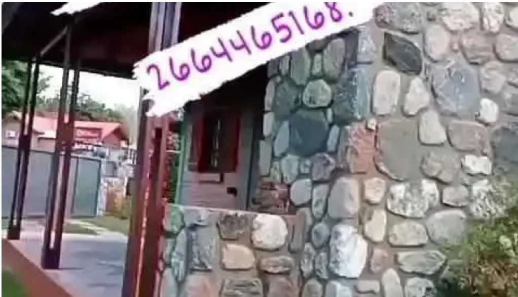
Los estribos exterior
