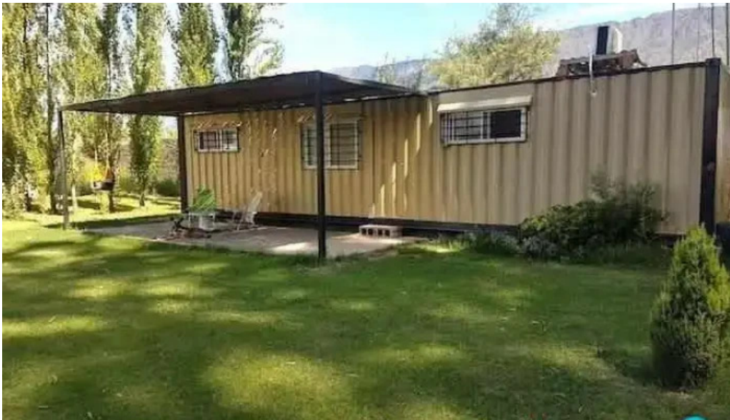
Casa container exterior
