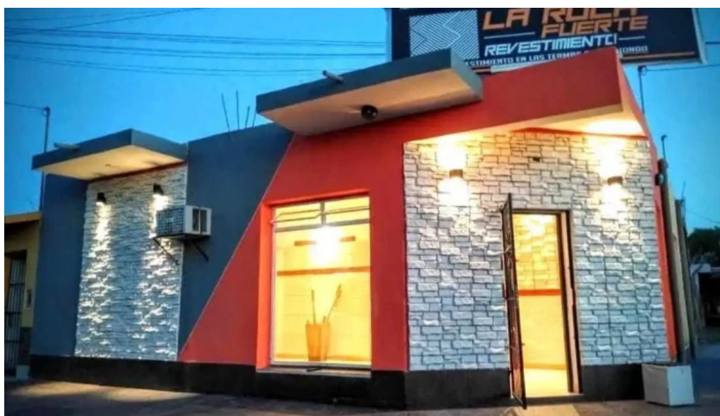
Revestimiento la roca fuerte exterior
