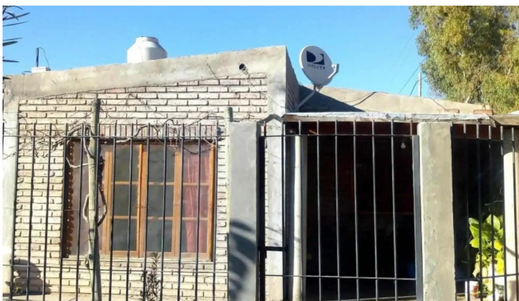
Barrio obrero municipal exterior
